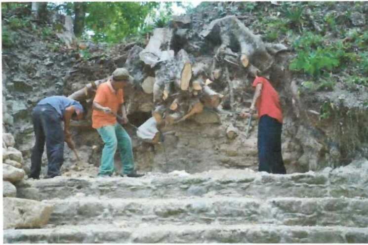
Proceso de limpieza, previo a restauración del cuerpo superior del alero sur de la fachada oeste edificio B-17. Fotografía Livni Almira, 2021.
