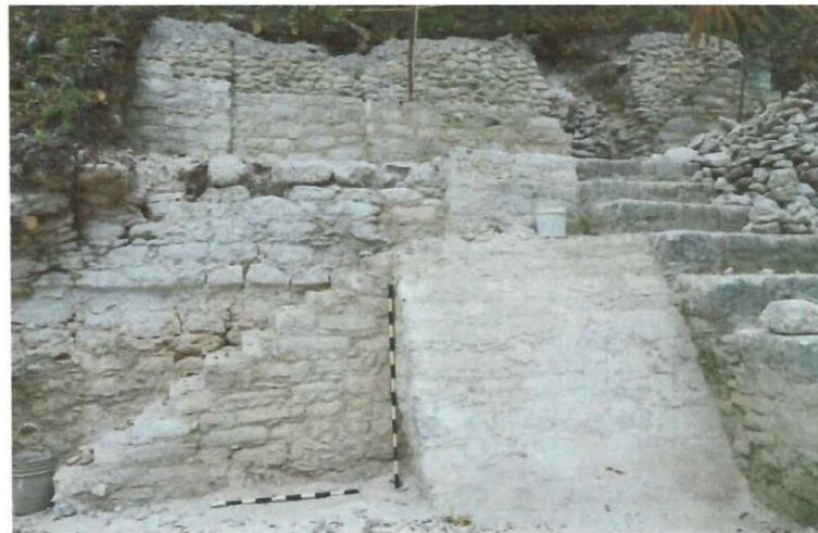
Restauración de edificio B-17, área de talud, gradas de acceso laterales, muro oeste inferior y muro oeste superior alero norte. Fotografía Livni Almira, 2021.
