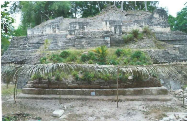
Restauración de grada 1 y 2 de acceso principal, del edificio B-17, y limpieza de grada 3. Fotografía Livni Almira, 2021.
